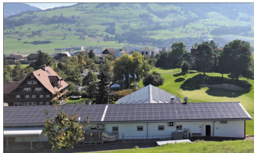
Die PV-Anlage auf dem Dach des Golfhauses.
